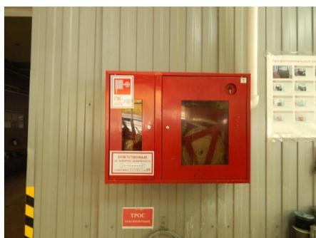
Рисунок 10 Оборудование противопожарного уголка
