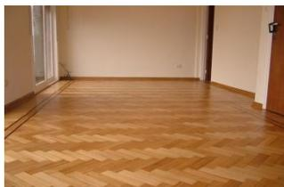
Следующее натуральное покрытие для пола - **штучный паркет**. Это деревянный пол, набранный из небольших дощечек. Изготавливается из натуральной древесины, является исключительно экологически чистым материалом; [Фото 3,4]
