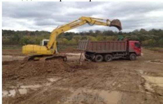
Рис.2 Вывоз плодородного слоя грунта со строительной площадки.
