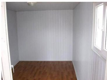
**Панели ПВХ (пластиковые)** - это полимерный отделочный материал, изготавливается из поливинилхлорида (ПВХ), мела и пластификаторов. [7]
