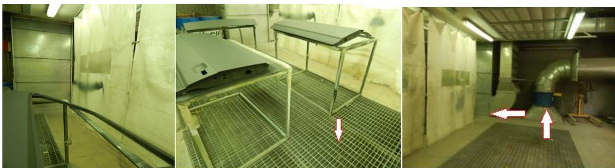
Рисунок 5 Очистительное оборудование лакокрасочной кабины
