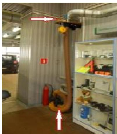
Рисунок 4 Приточно-вытяжная вентиляция отработавших газов
